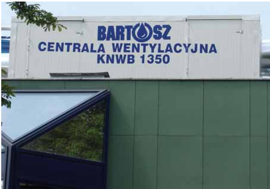
Rys. 2. Centrala dachowa z odzyskiem ciepła KNWB – monoblok
